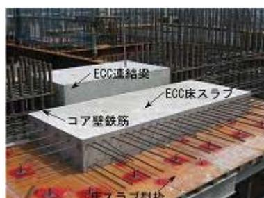
図 3.38 ECC 連結梁の施工状況
