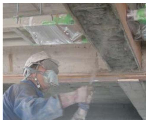
写真 3.3 吹き付け施工の様子
