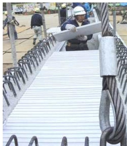
図 3.6 橋梁のコンクリート床版の下面底版に適用される PP-DFRCC パネル
