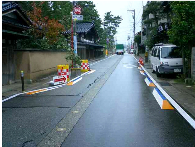
写真-3・3・2 双方向通行道路における狭さくの設置
