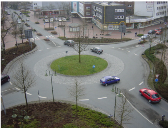
写真-3・4・3 改築後のロータリー交差点 (エア・エアケンシュヴィック (独))
