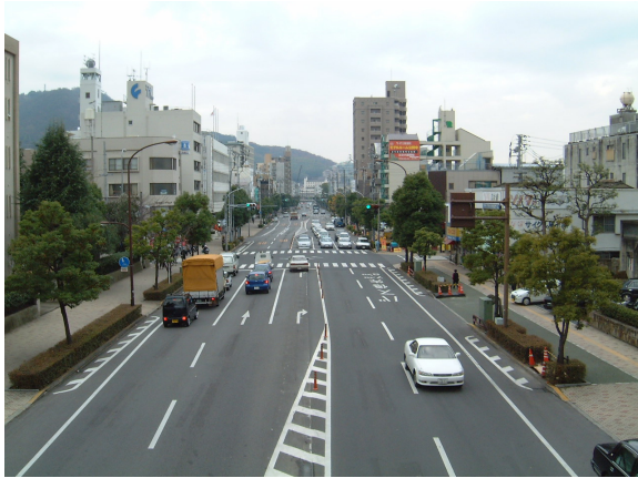
写真・3・4・1 再構築後の状況（項目 1）
