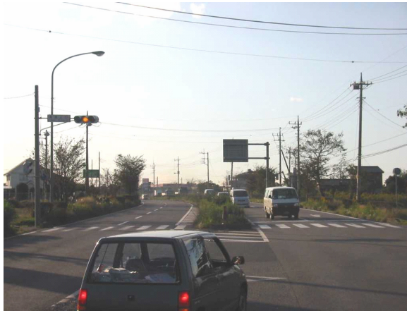
写真-2.4.3 道路X右折車線から対向車線の見え方
