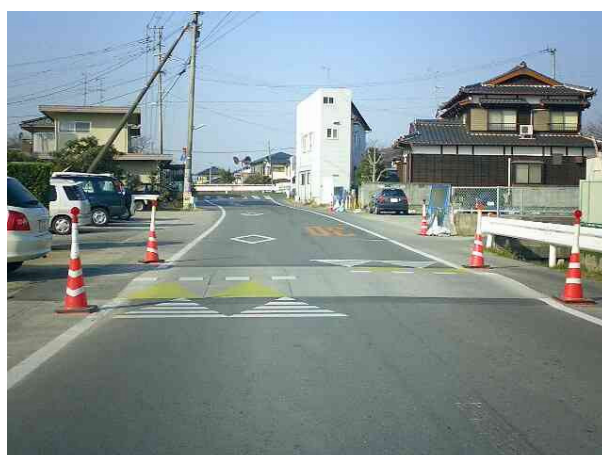
写真・3・3・1 ハンプ設置状況
