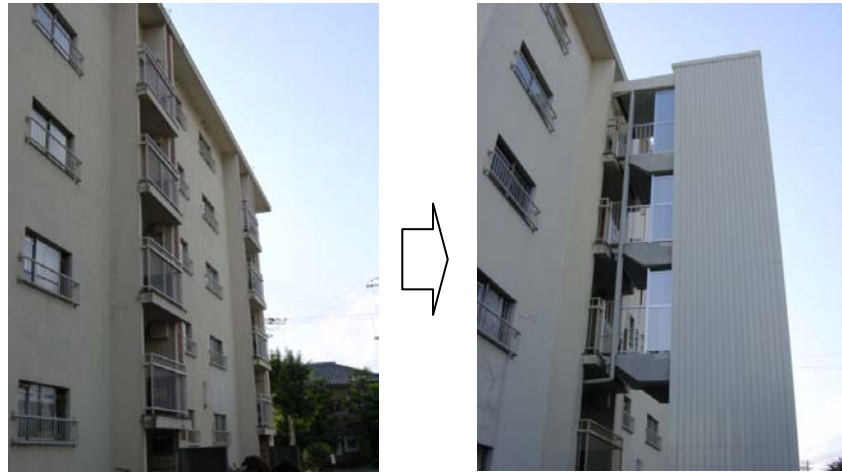
階段室踊り場へのエレベーター設置
