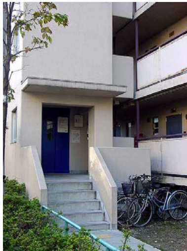
(左)エレベーターの新設
