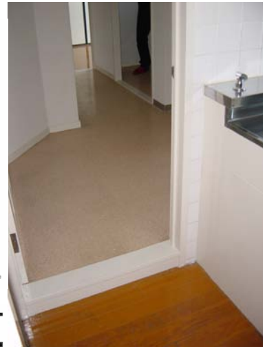
台所から開口した壁を通して見たところ。水回り部は一段高くなっている
