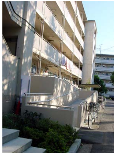
(右)エレベーターと同じレベルにある1階共用廊下に至るスロープを設
