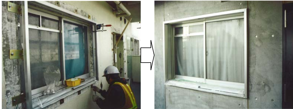
既存サッシの外側に新規サッシを取付け、外付けサッシの周りに外断熱パネルを貼込む
