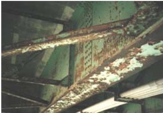
図 1-3-4 鋼桁橋の全体的な腐食
