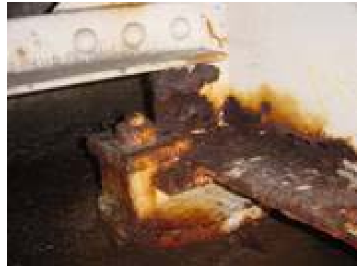
図 1-3-5 鋼主桁下フランジ端部の腐食
