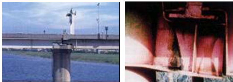
図1-6-7 連続性を確保するため桁端部を切り欠いた構造(左)と切り欠き部の疲労損傷(右)
