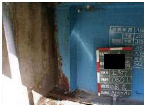
図 1-3-6 鋼主桁ウェブ端部の腐食
