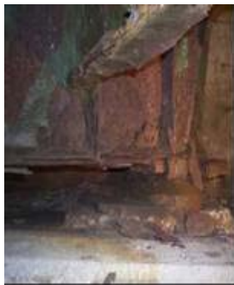
(a)主桁端部
