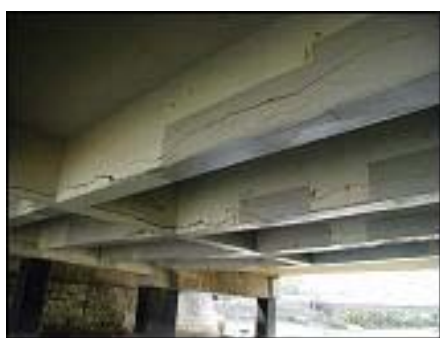
図1-0-3 塩害を受けたコンクリート橋
