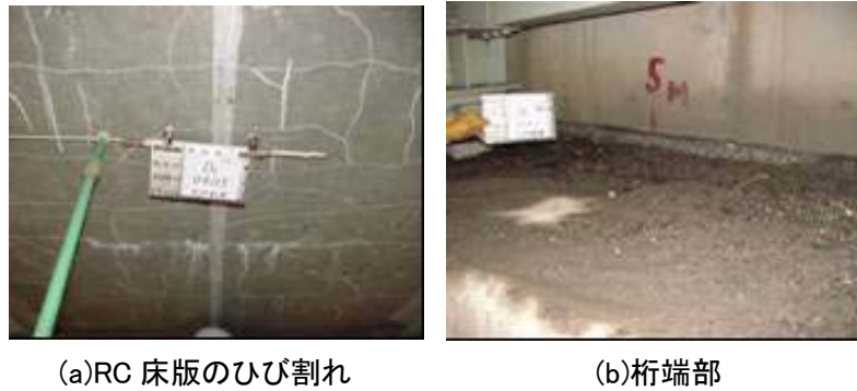
図1-6-4 C橋の状態
