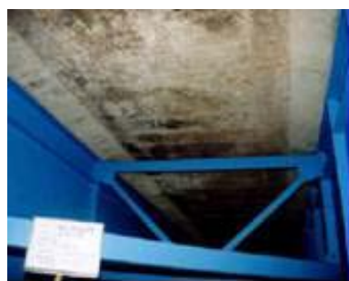
(a)RC床版のひび割れ
