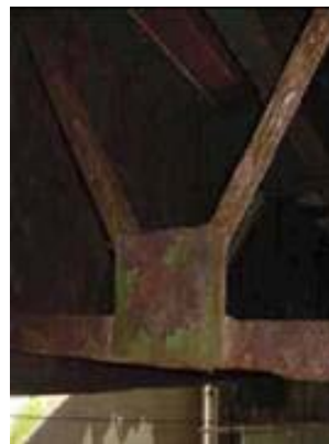
(b)主桁と対傾構
