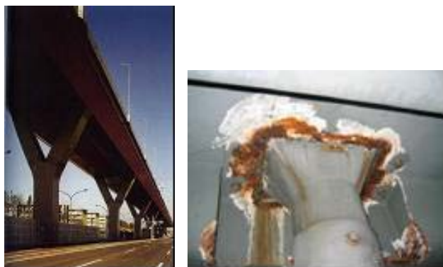
図1-6-5 配水管を隠した構造(左)と配水管周囲の腐食(右)
