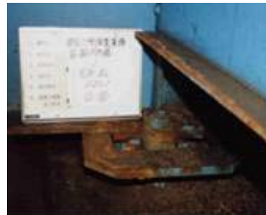
(b)桁端部の腐食
