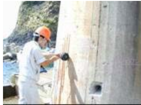
図1-3-3 コンクリート部材の非破壊検査
