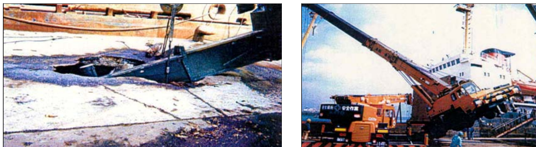
図1-4-4 係留施設での老朽化による発生事故
