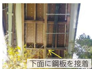
補強(鋼板接着)された床版の例
