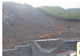
対策工事実施状況
