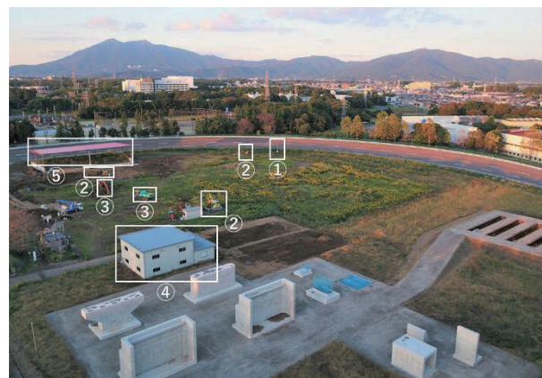
写真 建設DX実験フィールドに配備した土工フィールド全景
