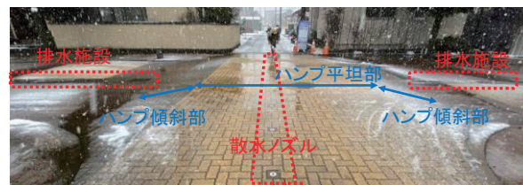
図-6 消雪パイプの設置事例
