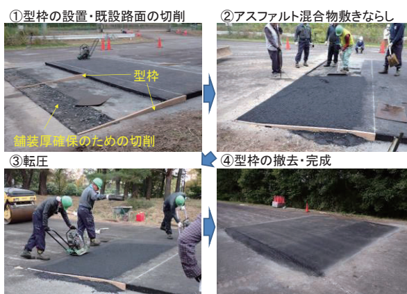
図-4 ハンプ傾斜部の施工手順
