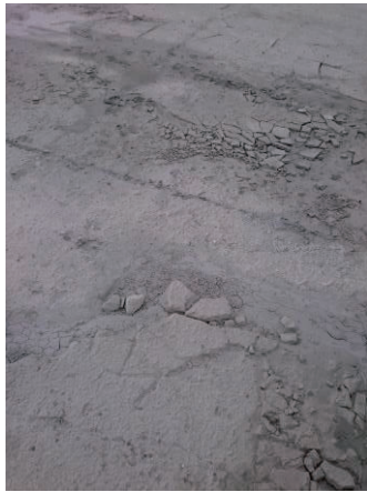
写真-1 既設PC版を撤去し露出させたグラウト層
