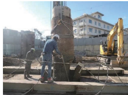
写真 調査現場での杭撤去時の状況
