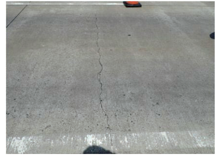
写真-1 カルバート上のコンクリート版に生じたひび割れ
