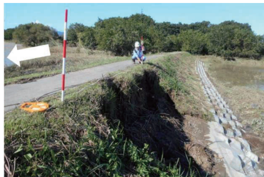
写真-1 危機管理型ハード対策箇所での裏法面の侵食事例（荒川水系都幾川[6.2kp左岸]）
