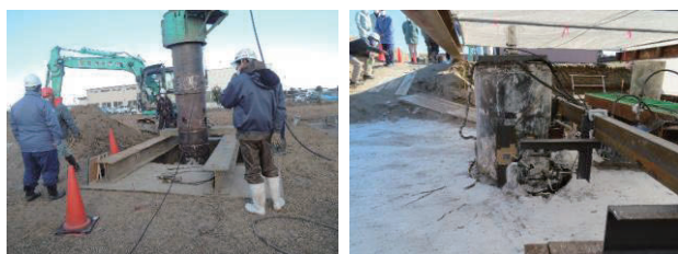
写真-3 既存杭の撤去後の地盤性状の検証
