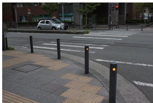
写真-1 ボラードの設置例(N型ボラード)
