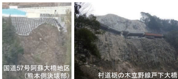
写真-1 急峻な斜面に近接する道路
