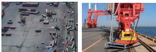
図-1 高潮等により発生した港湾の被害の例 1)
