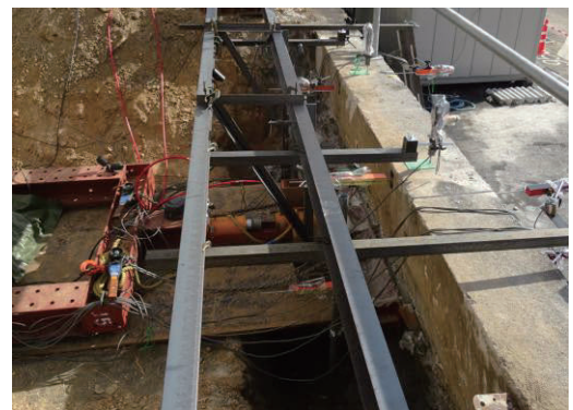
写真-4 宅地擁壁背面の载荷装置
