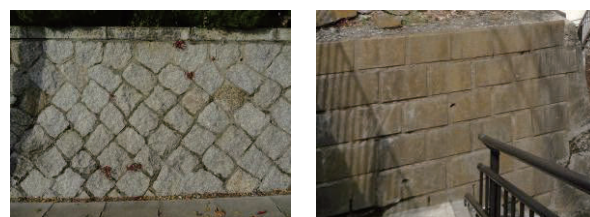
(a) 練石積み (b) コンクリートブロック積み
