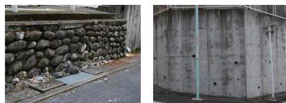
(c) 空石積み (d) 鉄筋コンクリート擁壁
