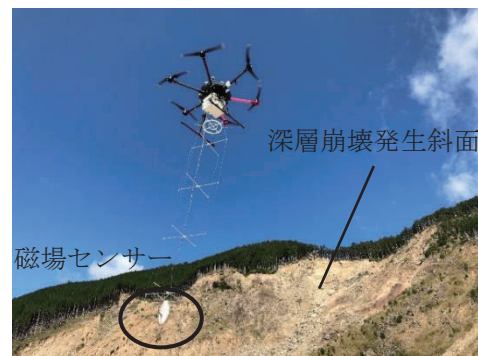
写真-2 ドローン空中電磁探査の様子
