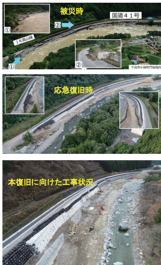
図 国道41号の被災写真と復旧状況
