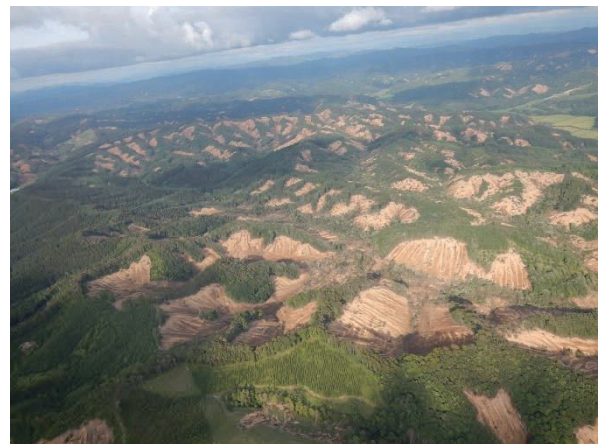
写真-2 北海道胆振東部地震による斜面崩壊の発生状況（2018年9月撮影）
