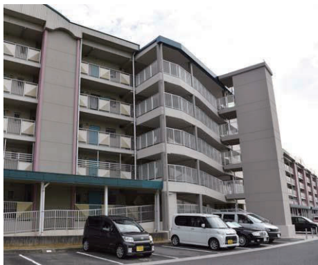
写真-1 2棟間へのエレベーター設置 (公的賃貸住宅)
