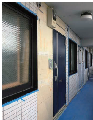
写真-2 外断熱+二重サッシ化による断熱性向上 (民間マンション)
