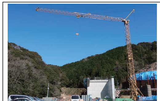
写真 定置式水平ジブクレーンをを用いた現場状況
