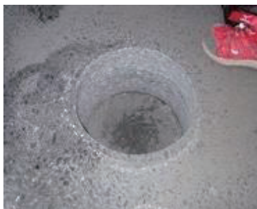
写真-3 コア採取孔 (健全区間)
