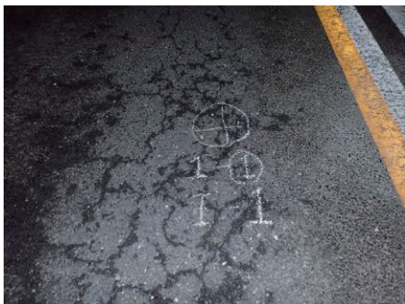
写真-1 ひび割れ発生状況
