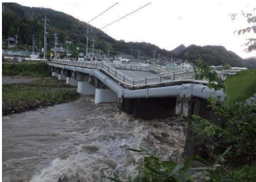
写真-1 法雲寺橋の被害
