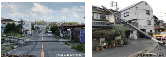
図-1 平成30年台風21号による電柱倒壊
