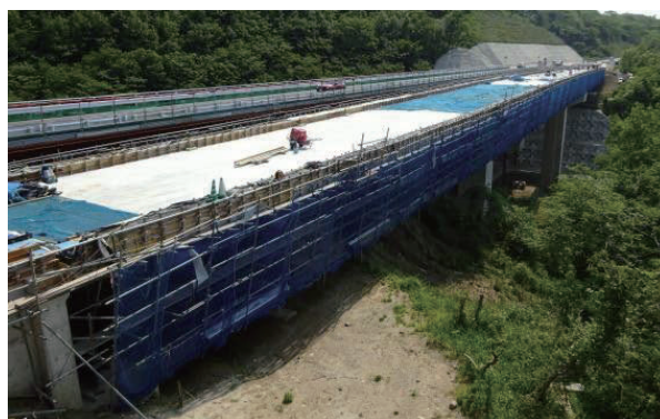
写真 復旧中の俵山大橋
