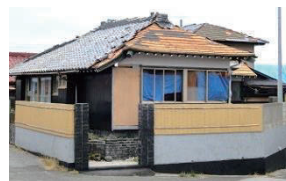
屋根ふき材の飛散
