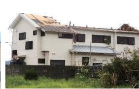
小屋組の損傷
