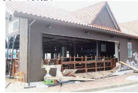
店舗の屋外に面する建具 (フロントサッシ) の損壊と転倒
