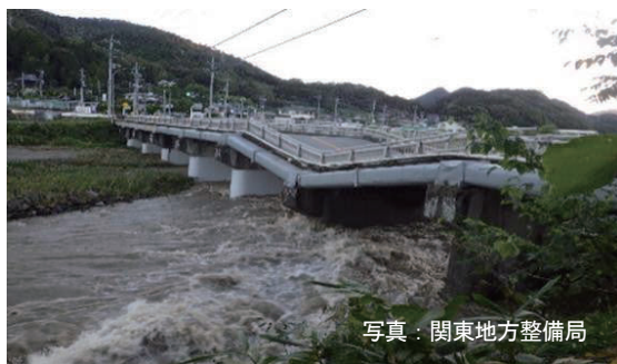
写真 橋脚の沈下が生じた国道20号法雲寺橋
