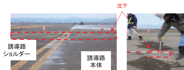
誘導路の被害事例(液状化によるアスファルト舗装の局所沈下)
