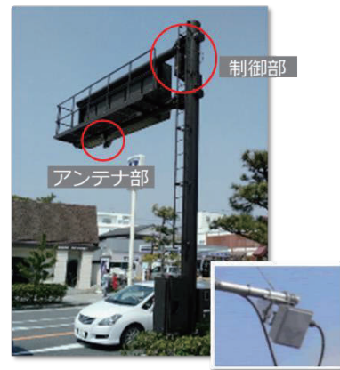
ETC2.0可搬型路側機の設置例
