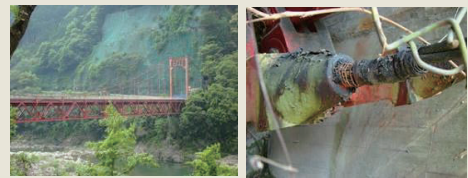
定期点検の質の向上が必要な事例 (吊橋は、近接目視だけでは、被覆下のケーブルの状態の把握が難しい)
