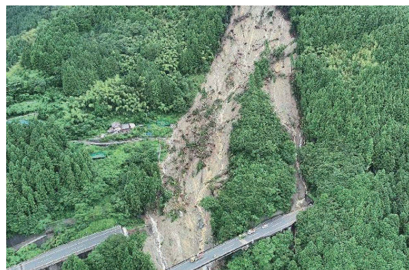
被災状況 (提供：西日本高速道路株式会社)
