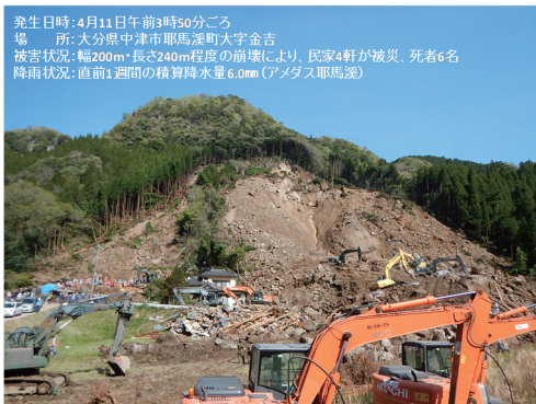
写真-1 大分県中津市で発生した無降雨時等崩壊
