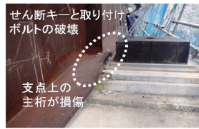
図-1 熊本地震による橋梁支承部の損傷例
