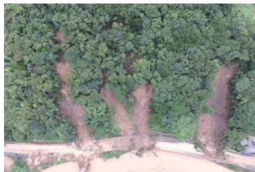
写真1 国道56号宇和島市吉田地先表層崩壊
