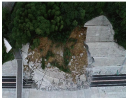
写真5 唐津伊万里道路のり面崩壊
