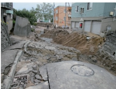
写真4 札幌市清田区里塚地区液状化(大規模噴出)
