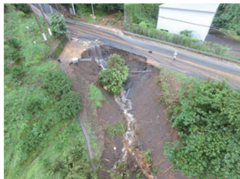
写真2 国道56号 宇和島市吉田地先のり面洗掘
