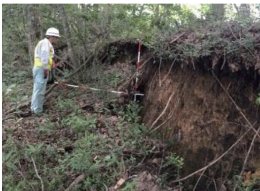
写真3 尾道松江道高野IC地すべり頭部滑落崖
