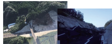
橋梁上部構造の流出や道路の閉塞により道路機能に影響を及ぼした事例
