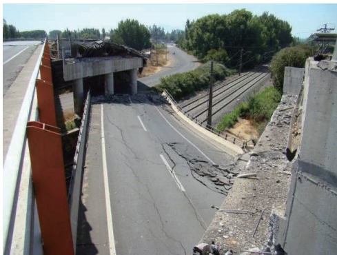
写真1 2010年チリ地震による落橋被害
