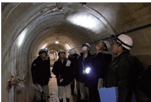
写真-1 ダム総合点検の実施状況
