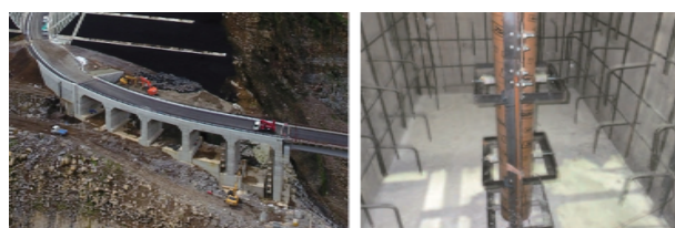
写真1 地震による阿蘇長陽大橋の被害状況
