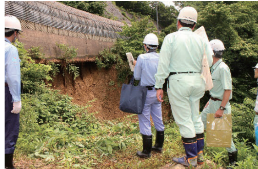
写真2 登り谷スノーシェルターでの現地調査状況
