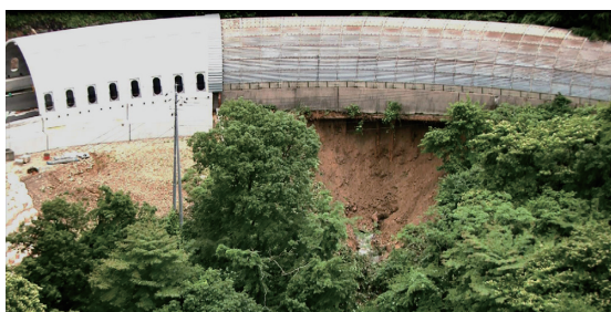
写真1 登り谷スノーシェルター 被災箇所全景
