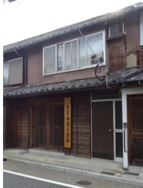
写真2 金属製建具に改修された例
