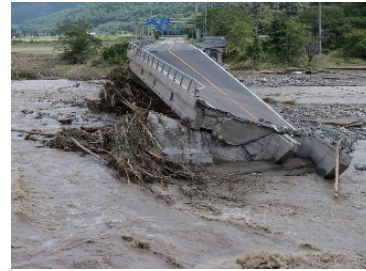
写真-1 洪水で被災した直轄管理国道の道路橋
