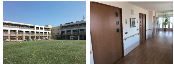
写真 用途変更 (学校からサービス付き高齢者向け住宅と保育所への転用) の例 (※ 規模に応じ排煙設備、内装制限が必要になり、現状では対応が困難な場合が多い)
