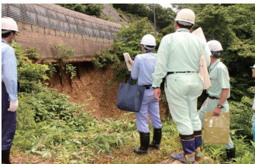
写真 災害時の現地調査
