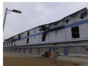
火災後の建築物の外観
