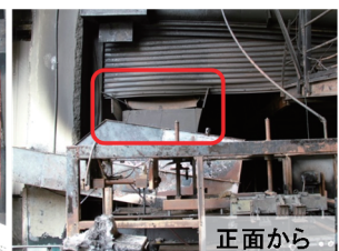
正面から コンベアによる閉鎖障害
