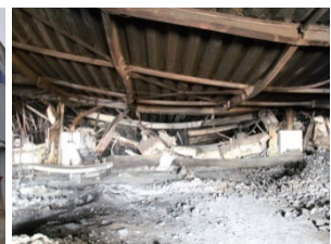
火災による屋根の崩壊
