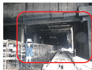
防火用シャッターの不作動
