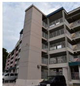
2住棟間にエレベータ設置した高齢化対応改善例
