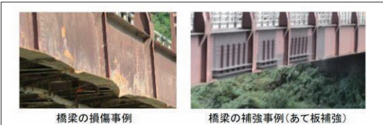
橋梁の損傷事例
