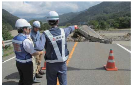
写真1 千呂露橋(国道274号)での現地調査状況
