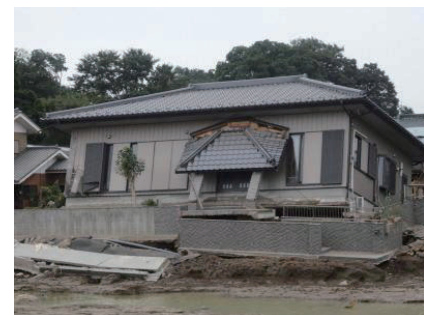
写真2 洗掘による被害を受けた木造住宅
