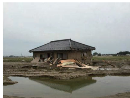
写真1 構造躯体が大破し流出した木造住宅
