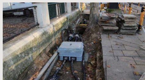
写真2 ロンドンの電力線の埋設事例
