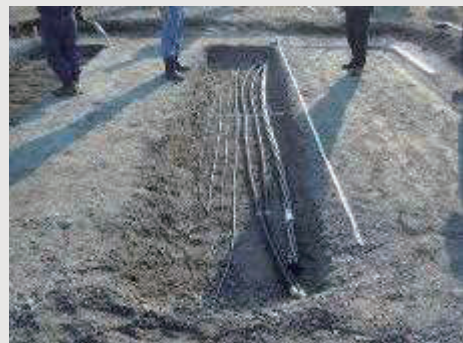
写真1 埋設したケーブル損傷等の検証
