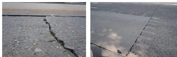
(a) 亀裂・段差 (b) パーステッチ工法 写真-3 コンクリート舗装の損傷例・補修事例
