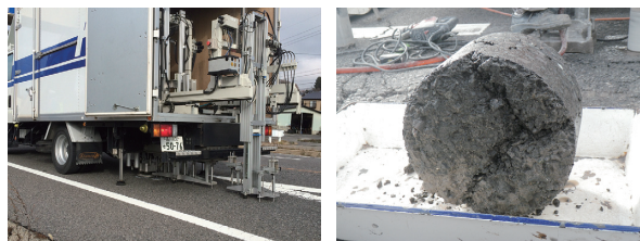
(a) たわみ量測定 (b) コア採取・分析 写真-2 アスファルト舗装の構造調査
