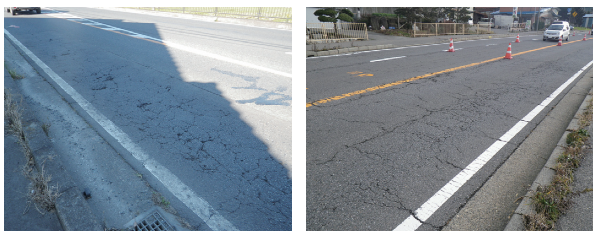
(a) 補修後約5年で破損 (b) 補修後約9年で破損 写真-1 アスファルト舗装の早期劣化区間の例
