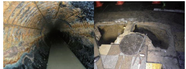
図-2 下水管の腐食(左)と歩道の陥没(右)
